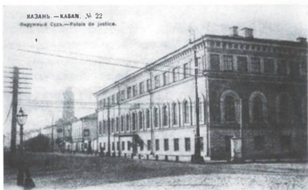
Здание Казанского окружного суда
